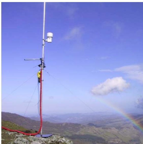
Monte Beni - stazione meteo
